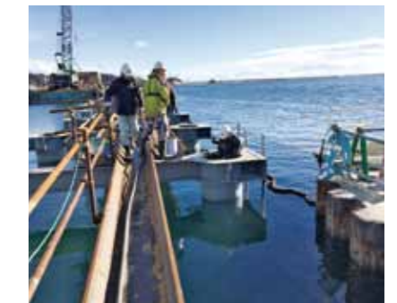
鋼製梁の間詰め (水中部)
