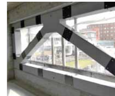
耐震ブレース廻りへの充填
