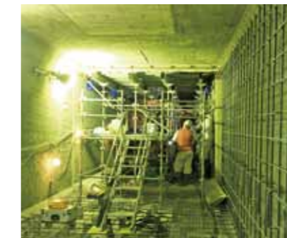
頂版下面 (型枠) への充填
