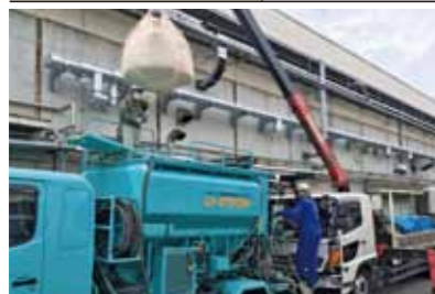
打設量によって、チャージ車(各種サイズ)も現場へ。 特に、住宅地などでは大型車両規制の確認が不可欠
