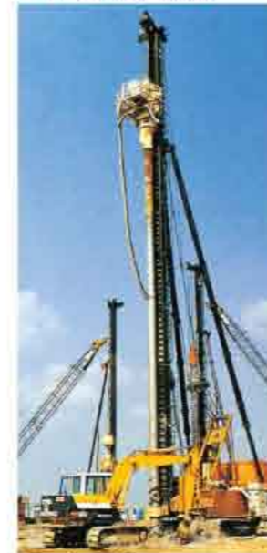
【石灰パイル工法】
