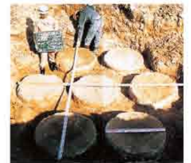
【施工後の検測】
