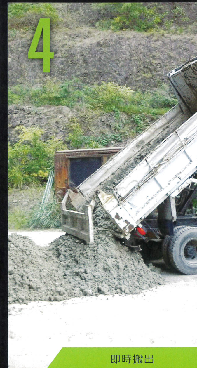
ダンプトラックに積み込み
